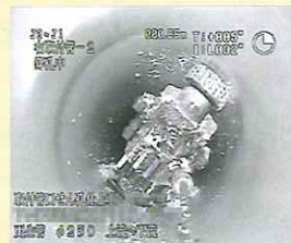
取付管穿孔仕上
